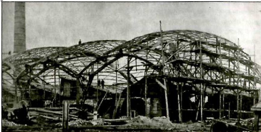
Строительство первых в мире сетчатых оболочек перекрытий двоякой кривизны конструкции Шухова
