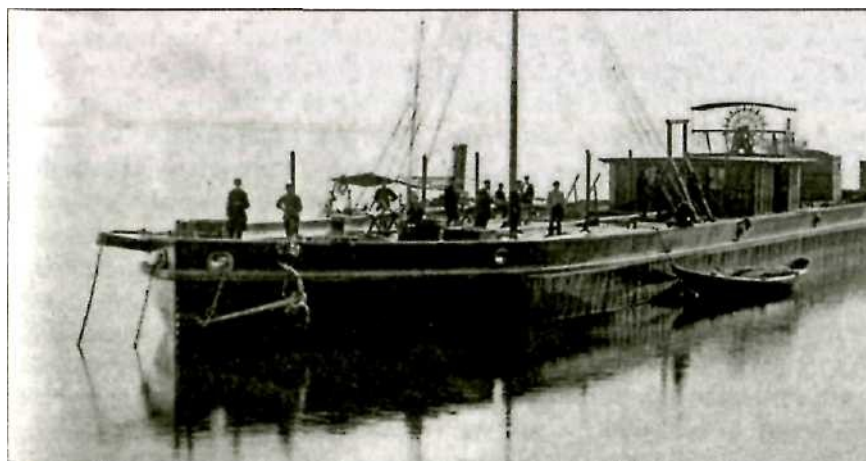
Железная наливная баржа. Построена по проекту В.Г. Шухова строительной конторой инженера А.В. Бари
