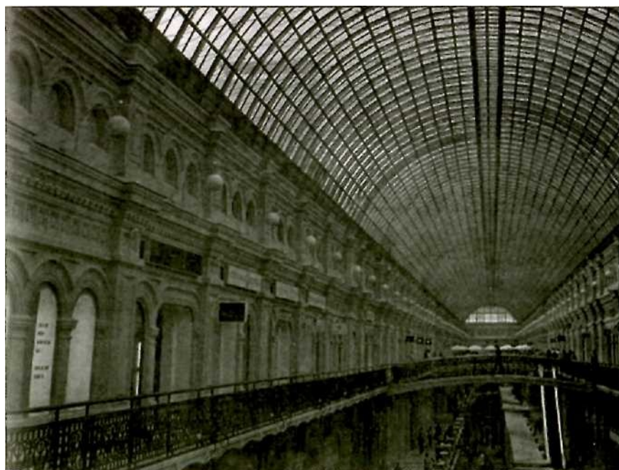
Металло-стеклянные перекрытия ГУМа конструкции Шухова
