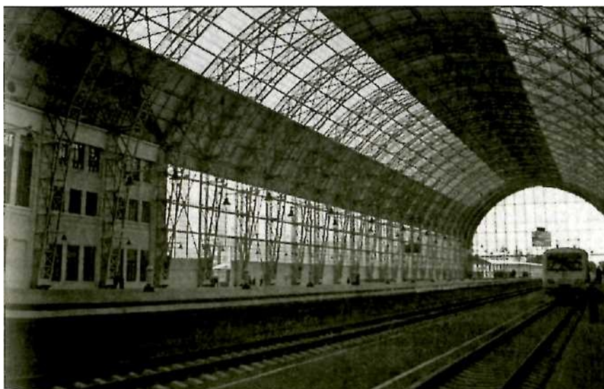
Шуховский металло-стеклянный дебаркадер Киевского вокзала в Москве
